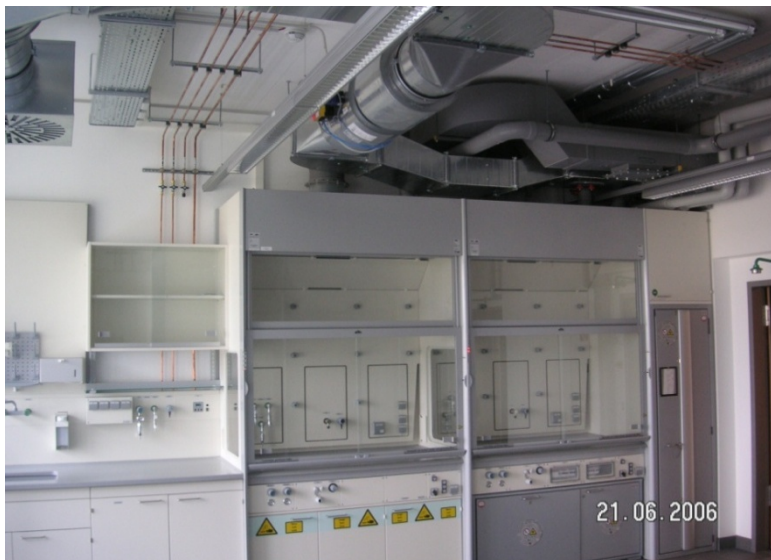
Bild 1: Laborraum mit typischen Be- und Entlüftungssystemen
